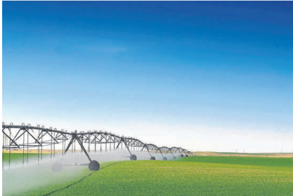
Equipos de aspersión en una obra de regadío. INGENIEROS AGRÓNOMOS ARAGÓN, NAVARRA Y PAÍS VASCO
