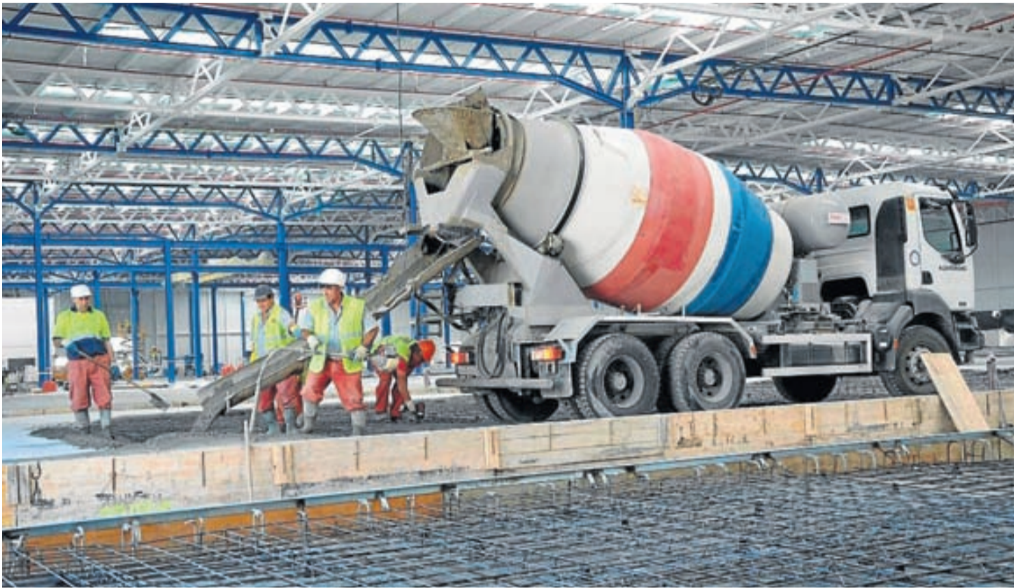
Varios trabajadores recubren con hormigón el suelo de una explotación ganadera. HERALDO
